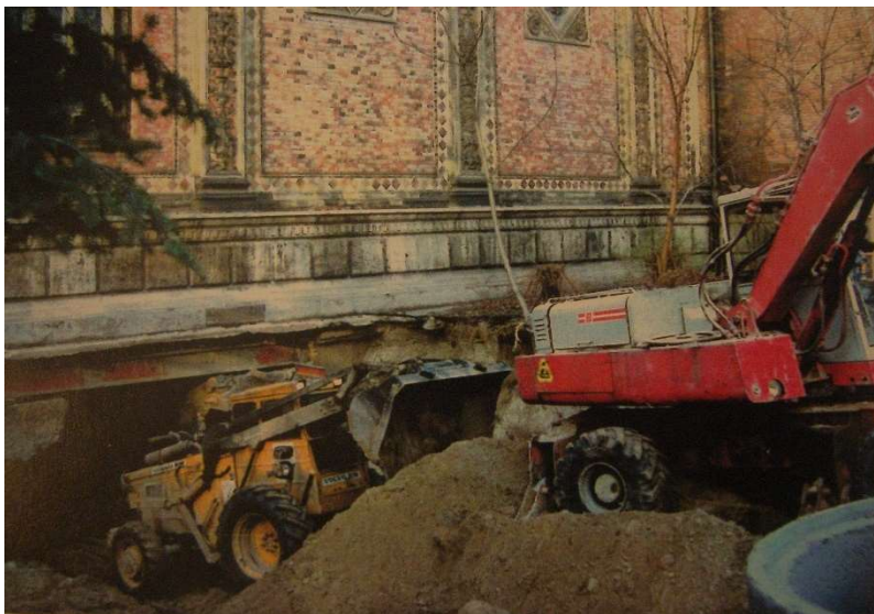
A Múcsarnok jégpálya felőli oldalán az új kondenzátorház felőli földmunkák az 1990-es évek elején
